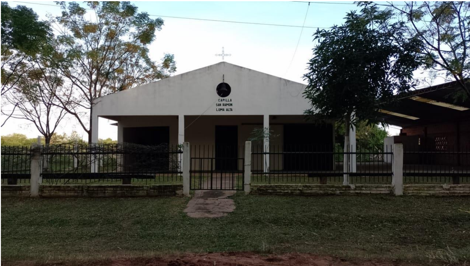
CAPILLA de San Ramón Nonato (Loma Alta) imagen Micaela Aguirre-Nieta de Nicasio Aguirre-Bisnieta de Teodosio Aguirre). Esta capilla fue asentada sobre Adobe, una mezcla de barro y a veces mezclada con paja(espartillo), con forma de ladrillo secada al sol, se levantó la capilla.
